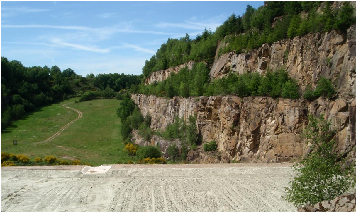
Figure 2 Stockage de boues et sédiments recouverts d'une couche d'argile (photo by N. v. Heesch, 21 Mai 2011)
